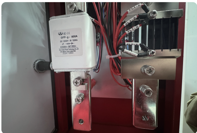
(液冷终端柜正负极接线实拍图)
