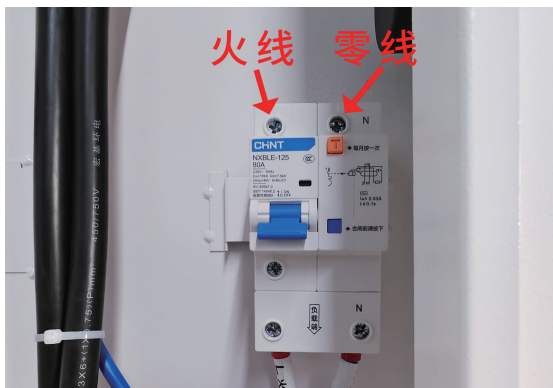
道闸内部接线示意图
